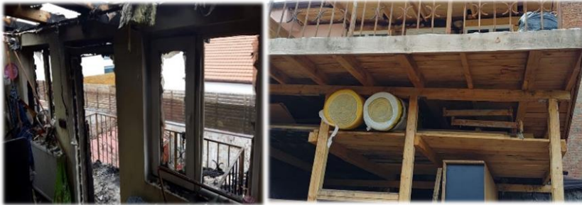
De reparaties zijn begonnen
